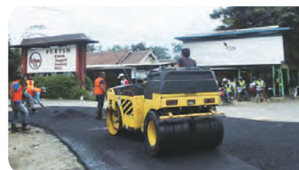
印尼子公司為當地社區修繕道路
